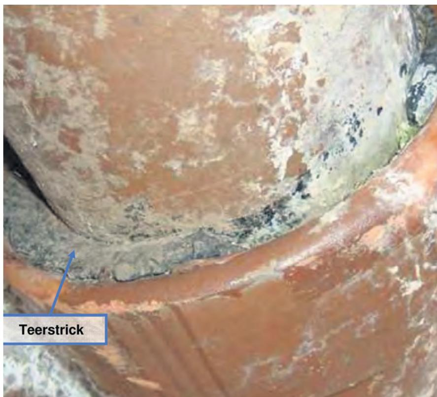
*Fehlende oder schadhafte Dichtungen sollen bei der Untersuchung erkannt werden.*
